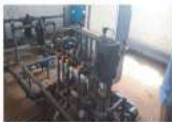
Hệ thống cung cấp nước tưới nước và tưới phân công nghệ Israel Tại Trung tâm
