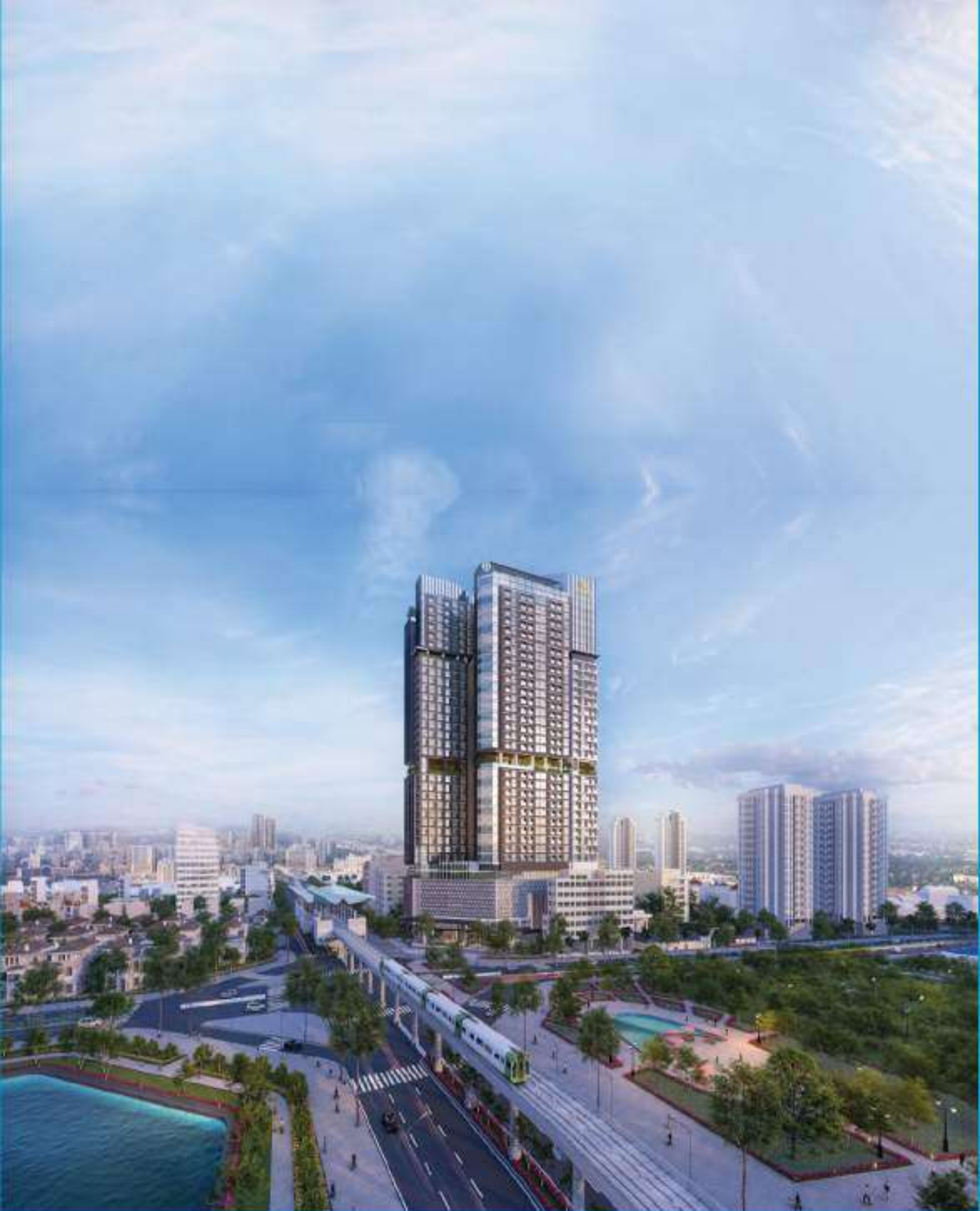
MECO thi công công trình toà nhà hỗn hợp dịch vụ thương mại, văn phòng khách sạn Địa điểm: Km9 đường Hồ Tùng Mậu, phường Mai Dịch, Quận Cầu Giấy, Tp Hà Nội
