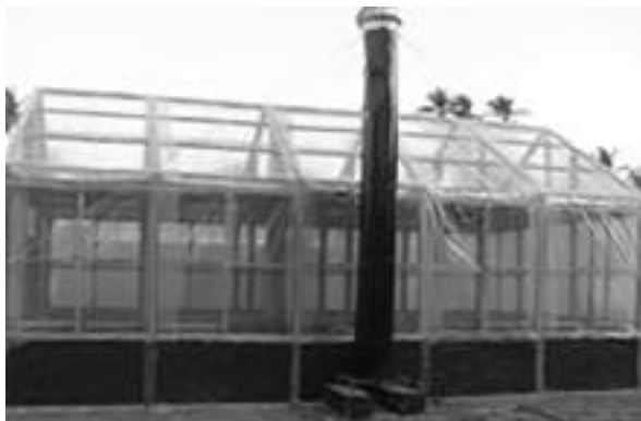
Hình 9. Nhà sấy thiết kế ống hút khí thải đặt bên ngoài [8]
