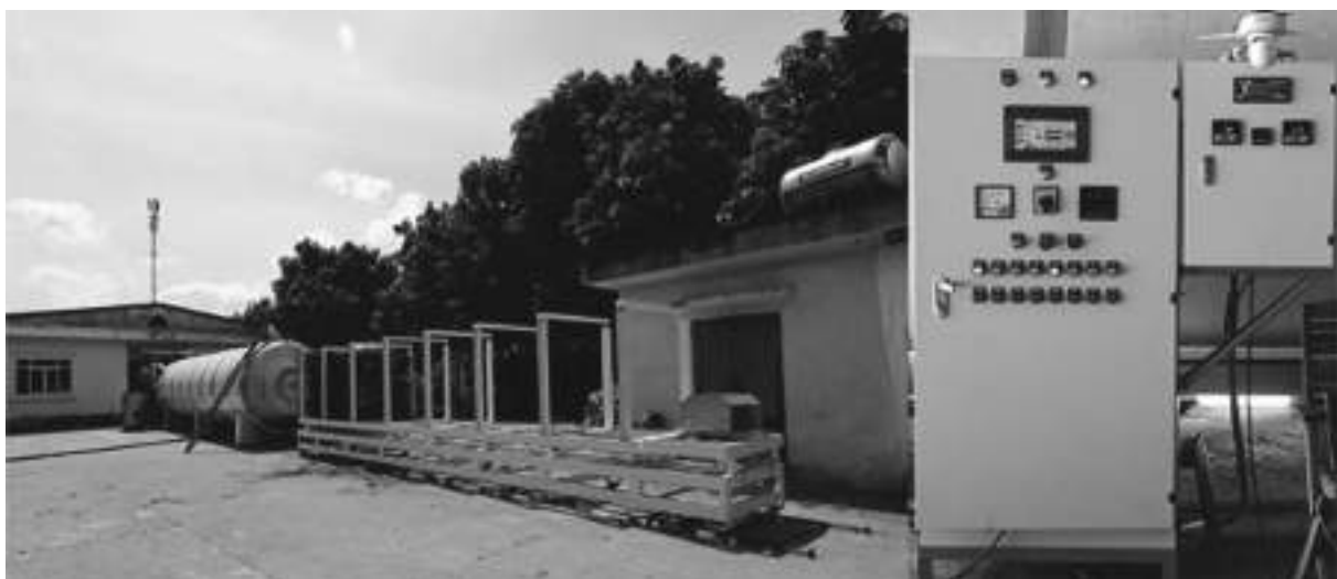
Hình 3. Hệ thống sấy gỗ bằng công nghệ bơm nhiệt chân không trong quá trình lắp đặt chạy thử nghiệm tại xưởng của Viện
