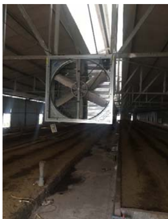
Hình 5. Hệ thống thiết bị điều khiển môi trường nuôi giun Hình 6. Hệ thống TB thủy phân
