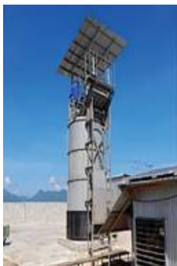
Hệ thống thiết bị và công nghệ xử lý phân gà công suất 2m 3 /ngày
